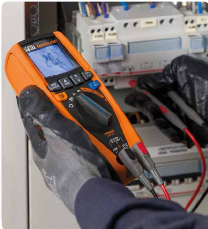
Měření napětí pomocí testovacího vedení test.
